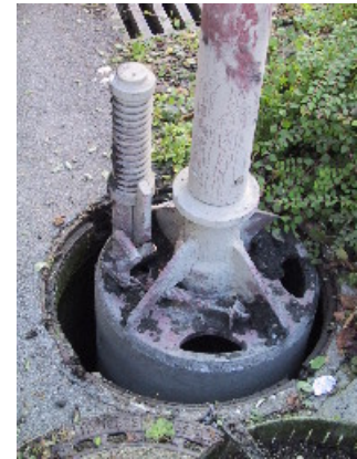
Bohreimer im Schacht
